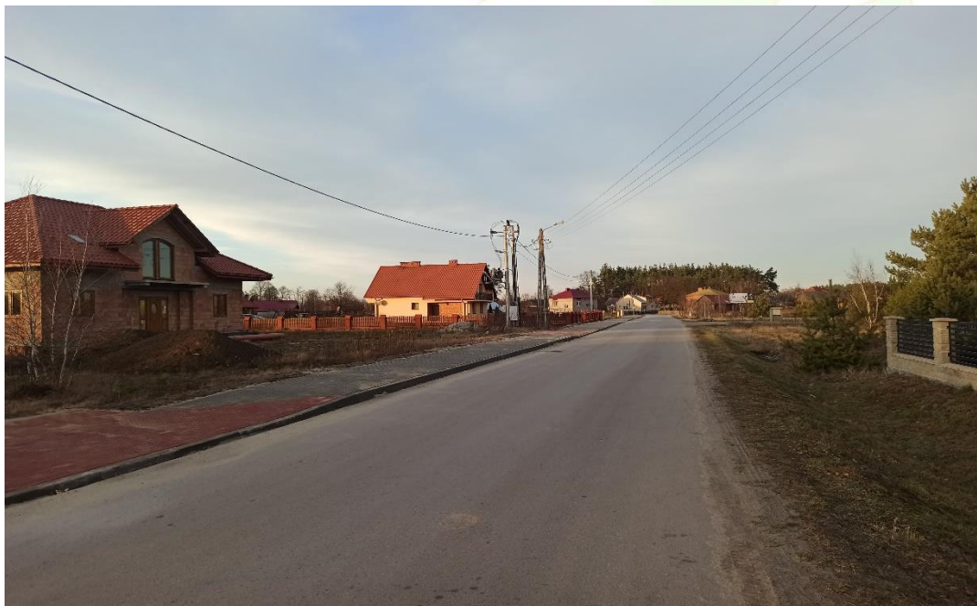
Fot. Wykonany chodnik na ulicy Łęgowej w Wilczej Woli.
