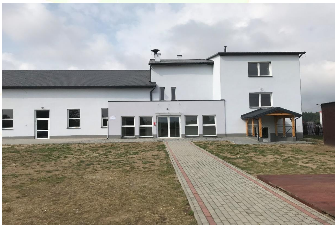
Fot. Budynek turystyczno – rekreacyjny w Wilczej Woli po modernizacji.
